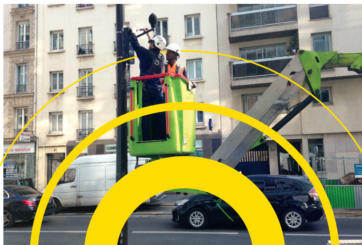
Installation d'une station de mesure rue Frémicourt (Paris 15 ème ) dans le cadre du projet LIFE Cool and low noise asphalts
